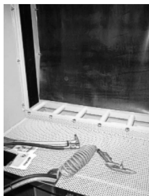
pohled do vnitřního prostoru pískovací kabiny
